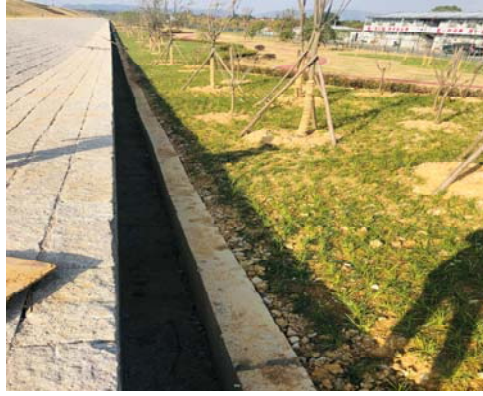
大坝坡脚排水沟
