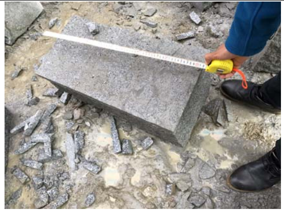
粗料石护坡石块尺寸检查
