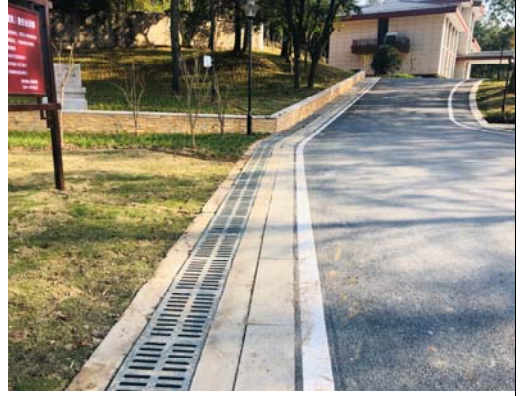
防汛道路排水边沟
