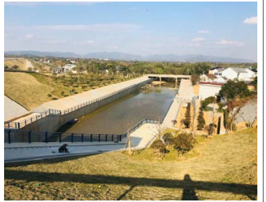
泄洪渠粗料石护坡
