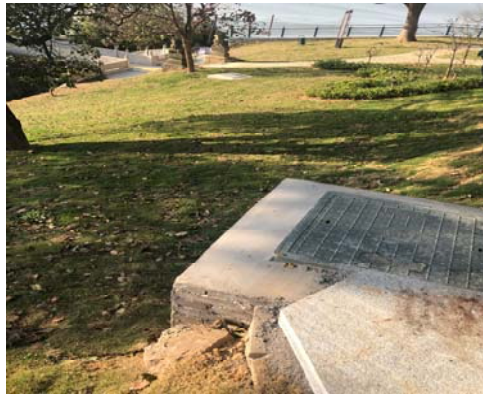
管理房区沉砂池
