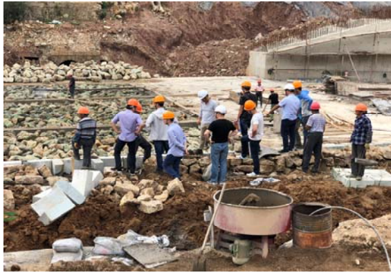
监测员现场了解施工进度
