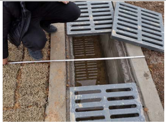
监测员现场测量排水沟宽度
